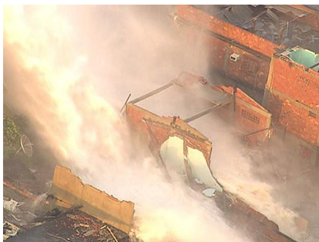
Figura 49 – Destruição de residência com o rompimento de uma adutora de água tratada.
