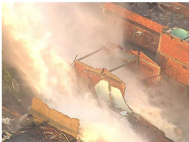
Figura 26 – Destruição de residência com o rompimento de uma adutora de água tratada.
