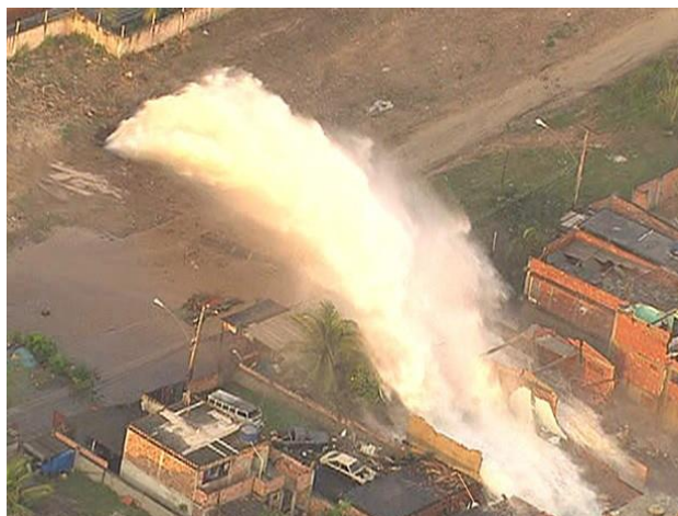
Figura 27 – Vista geral do rompimento da adutora de água tratada.
