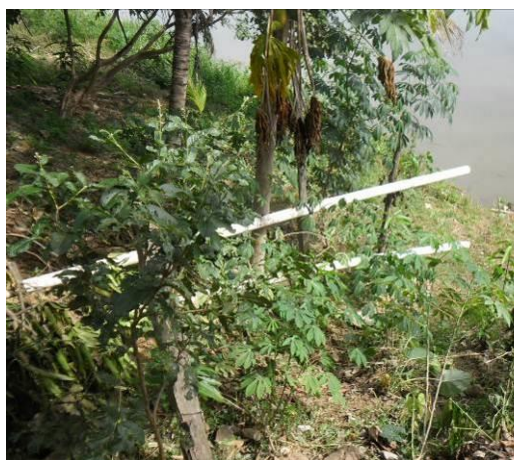
Figura 9 – Esgoto lançado in natura sendo lançado no rio.
