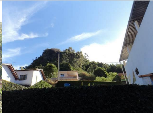
Figura 47 – Casas na base do maciço com risco de deslizamento.
