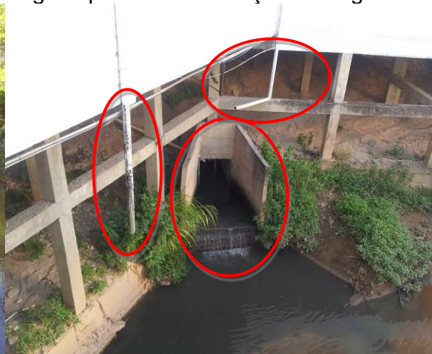
Figura 34 – Exemplo de galeria de águas pluviais e tubulação de esgoto.
