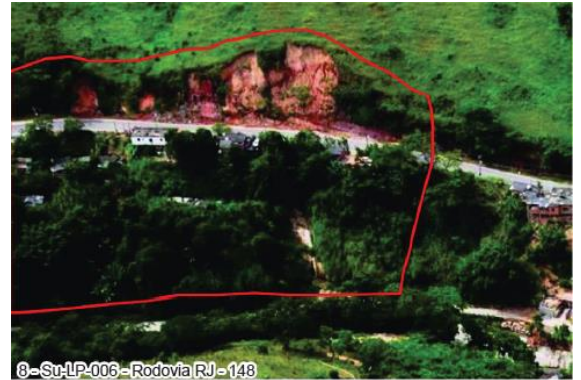
Figura 50 – Área de risco – Rodovia RJ - 148.
