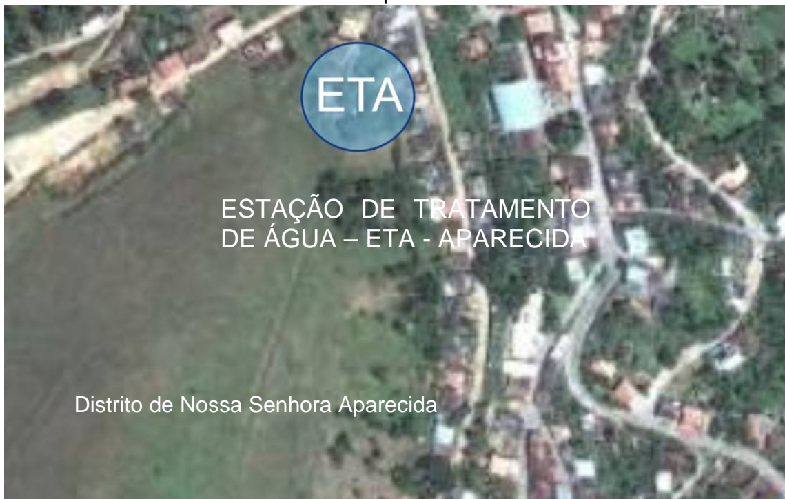
Figura 26 – Localização da estação de tratamento de água do distrito de Nossa Senhora Aparecida.
