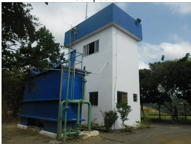
Figura 27 – Vista lateral da estação compacta.
