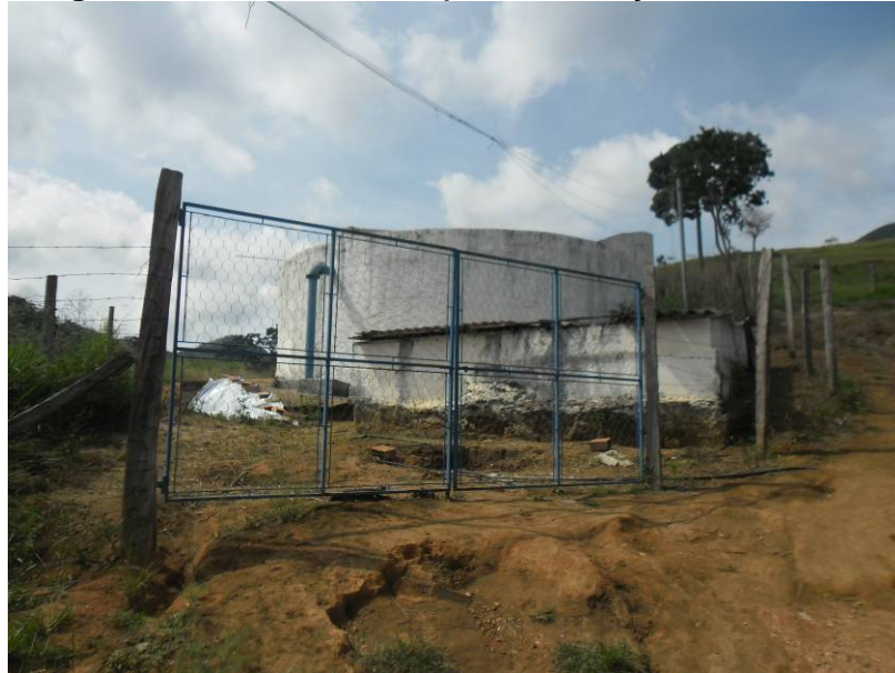
Figura 41 – Reservatório junto à estação de tratamento.
