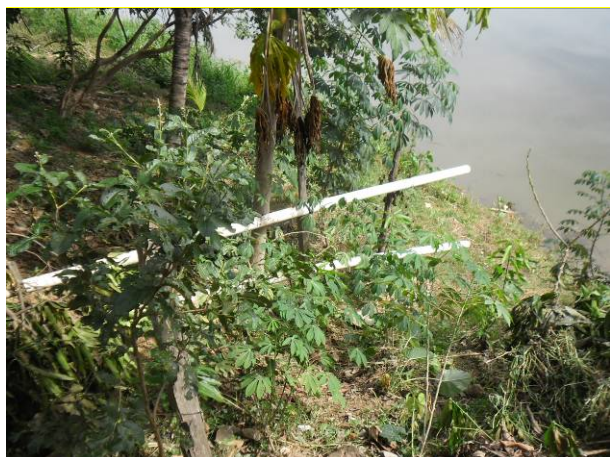
Figura 70 – Esgoto lanado in natura no rio Paraba do Sul, distrito de Jamapar.
