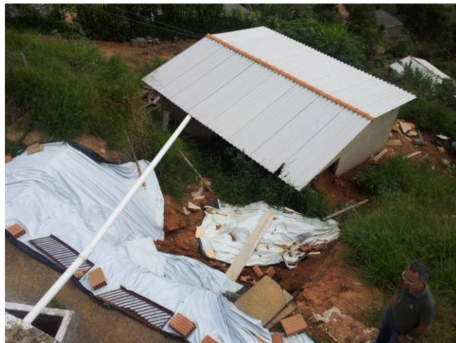
Figura 43 – Instalação de água diretamente do reservatório.
