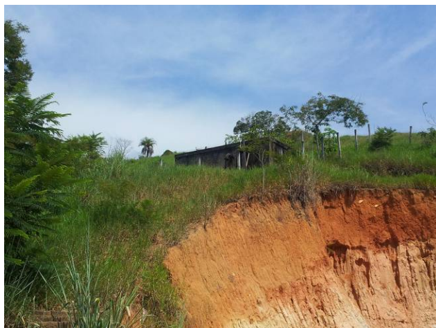
Figura 23 - Reservatório de Jamapará.
