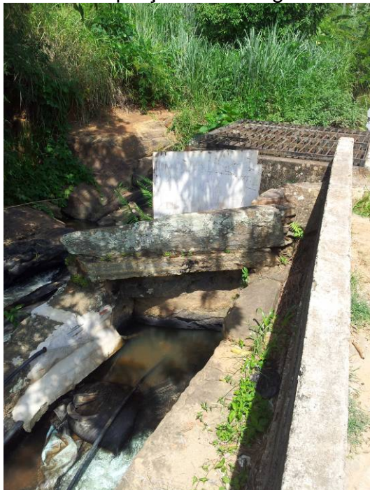
Figura 15 – Captação do córrego do Curtiço.
