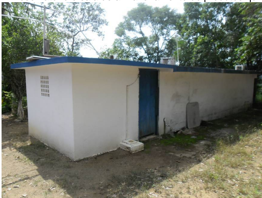
Figura 29 – Reservatório e sala de armazenamento de produtos químicos.
