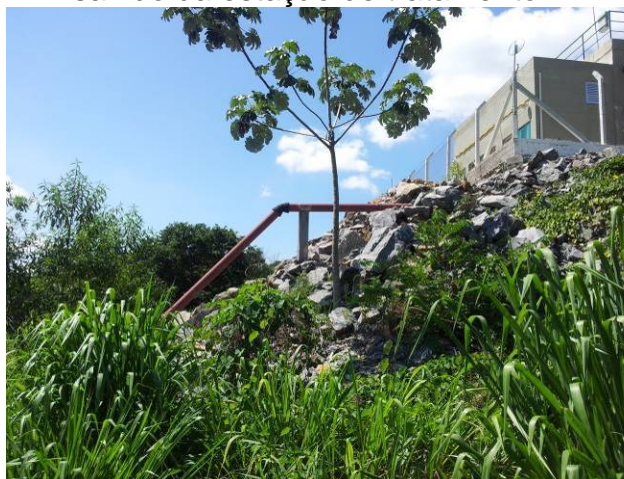
Figura 61 – Rede de efluentes tratados saindo da estação de tratamento.
