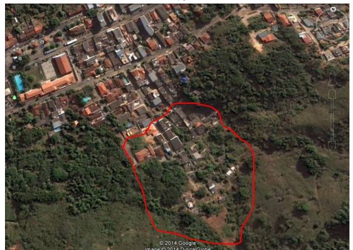
Figura 83 – Maonaria – Risco Moderado a Alto.
