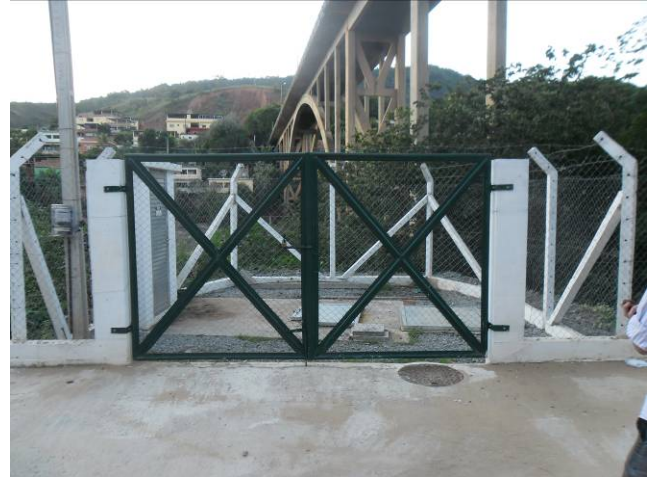
Figura 54 – Vista de Frente da Estação Elevatória – Final de Sapucaia.
