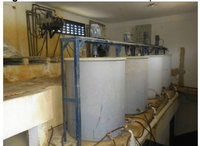
Figura 20 – Sala de misturados qumicos.
