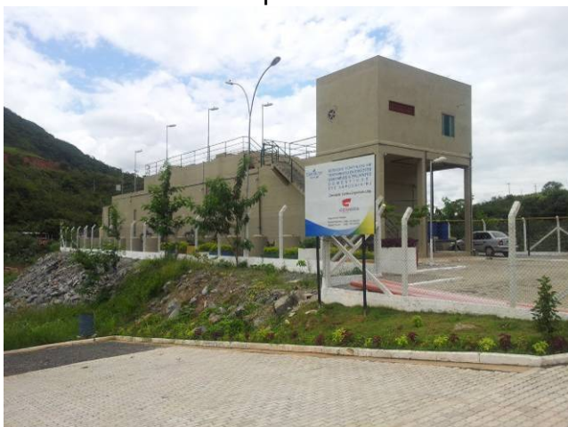
Figura 57 – Estação de Tratamento de Esgoto - Sapucaia
