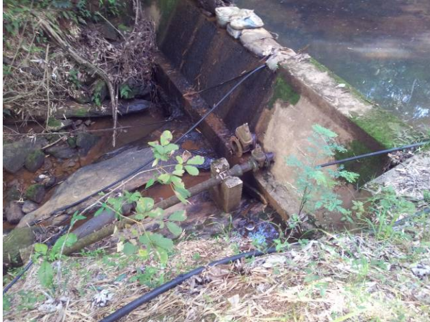
Figura 11 – Captação do Córrego Monte Livre.
