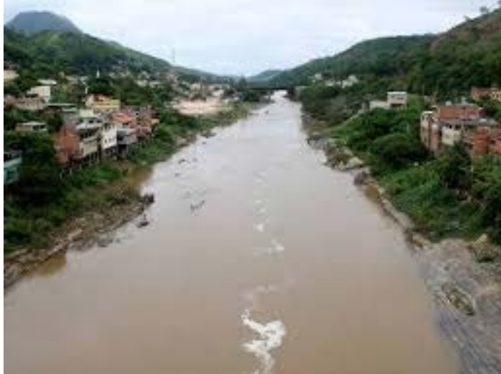
Figura 88 – Presença de moradias próximas ao Rio Paraíba do Sul em Sapucaia.
