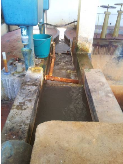
Figura 5 – Chegada de Água Bruta.
