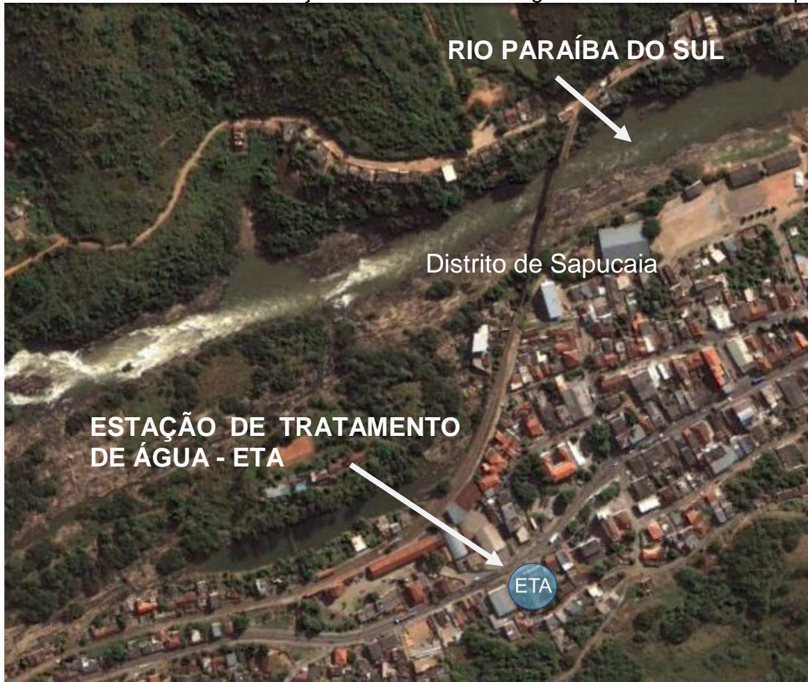
Figura 4 – Posicionamento da estação de tratamento de água do distrito Sede de Sapucaia
