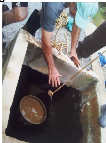
Figura 40 – Retirada de lama.
