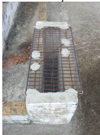
Figura 38 – Tampa de visita depois da intervenção.
