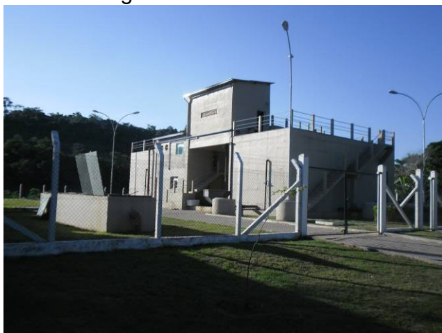
Figura 66 – Estação de Tratamento de Esgoto do Distrito de Anta
