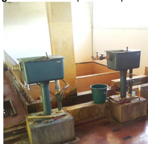
Figura 8 – Sala de produtos químicos.
