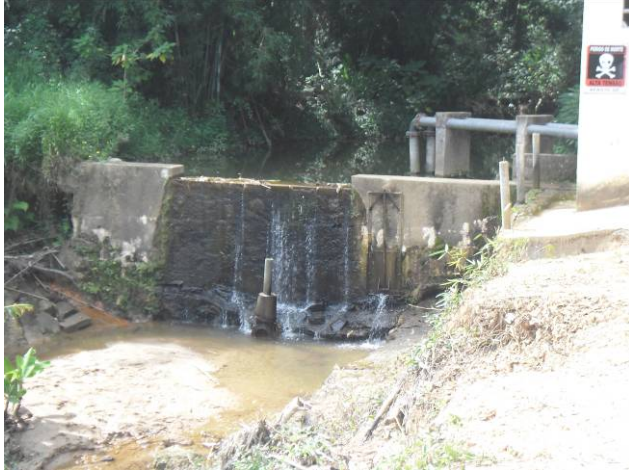
Figura 31 – Barragem da captação.
