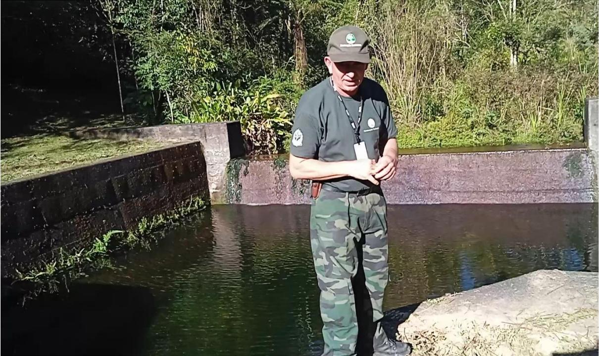
*Figura 70 - Vertedouro na foz de uma microbacia para fins de monitoramento hídrico, Parque Estadual da Serra do Mar, Cunha SP.*
